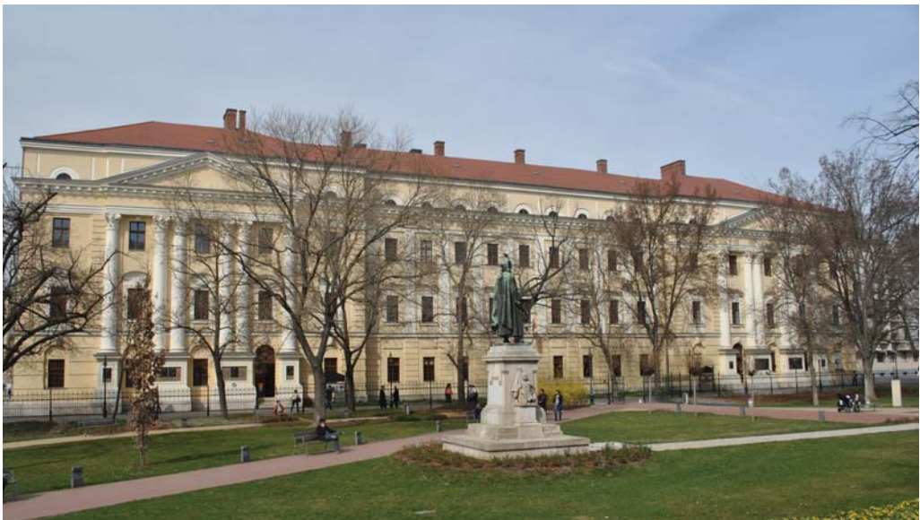
» A kollégium épülete ma
