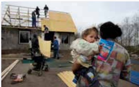
► Antal András atya katolikus lelképásztor és önkéntes segítői felújítják egy négygyermekes asszony víz és villany nélküli házának rozoga tetőszerkezetét
