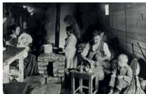
Vagonlakó család Budapesten ▪ Milyen körülmények között éltek a vagonlakók?
