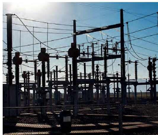
Az albertirsai transzformátorállomás elosztó berendezése
