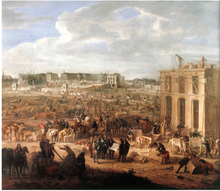
Versailles építése ■ Milyen eszközökkel dolgoztak? Mi okozhatta a legnagyobb problémákat az építkezés során?
